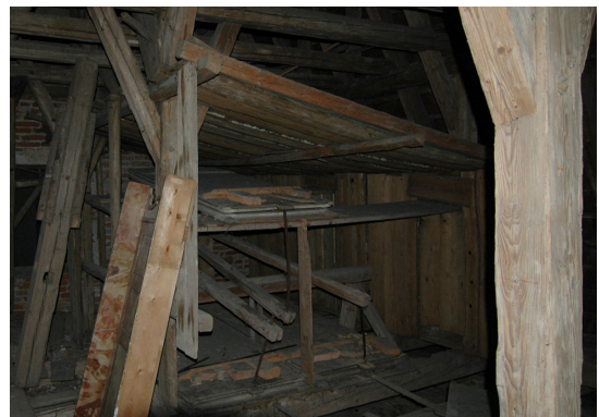
Abbildung 10: Pfarrkirche Kirchdorf am Inn, Reste einer originalen Keilbalkanlage
