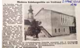
1954/55: Kindergartenbau und Pfarrheimeröffnung
